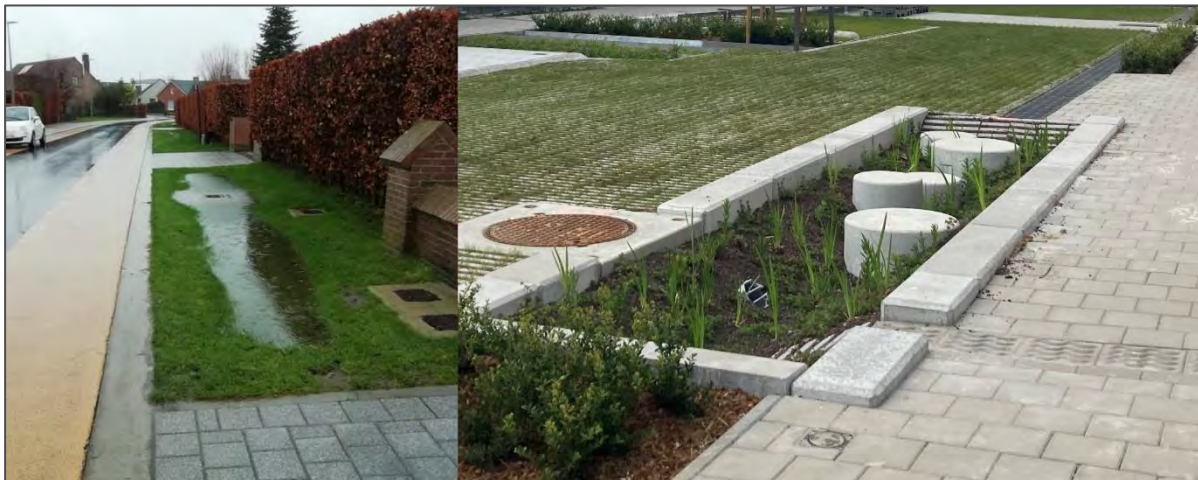
Figuur 17. Vlnr: (1) Infiltratiekom langs de straat (© Kruisem); (2) Bufferend plantvak (Aziëlaan Wilrijk, tuinstraat).
