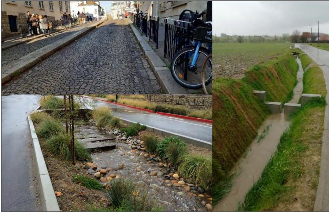
Figuur 19. Vlnr en vbno: (1) doorvoer waterloop in groenberm straat (© svrdesign.com); (2) verhoogde borduren van voetpaden in Parijs (© Aquafin) en (3) gracht met bufferschotten (© Kruisem).
