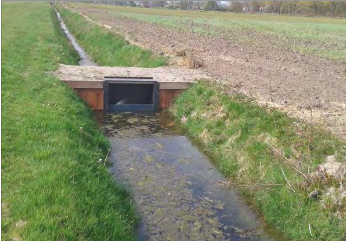
Figuur 27 Voorbeeld van een stuw (bron: Boerenatuur Vlaanderen)
