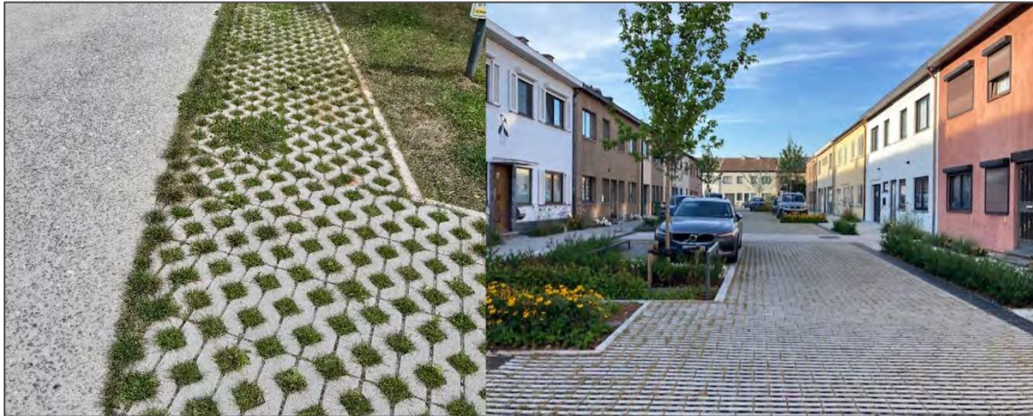
Figuur 13: Vlnr: (1) versmald voet-fietspad met uitwijkmogelijkheid over waterdoorlatende verharding (Overijse - © Aquafin); (2) tuinstraat met zowel rijweg als parkeervakken aangelegd in halfverharding (Aziëlaan, Wilrijk).
