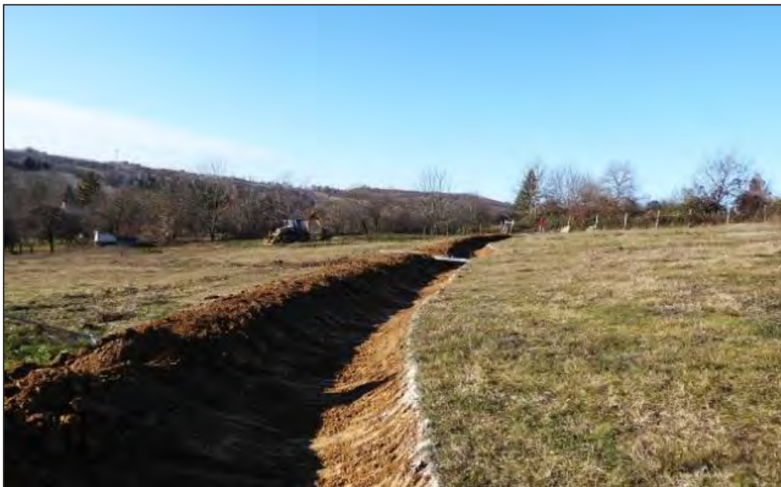
Figuur 29 Voorbeeld swale in landschap (Bron: Water-Land-Schap)
