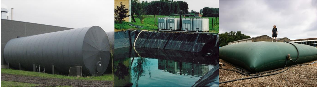
Figuur 52. Buffertanks, een foliebekken en een zak, voor de opslag van regenwater (Bron: Departement Landbouw en Visserij; Provincie Oost-Vlaanderen; De Standaard).
