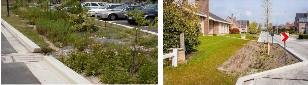
Figuur 35: Voorbeelden van gat in boordsteen (links onder) en verlaagde wegversmalling (rechts onder). Bron: Aquafin
