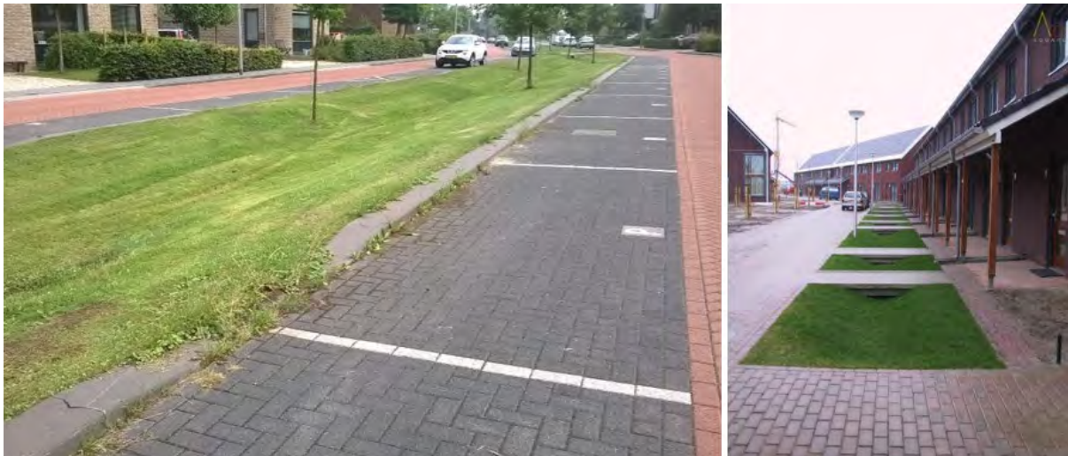
Figuur 23: Voorbeeld van laagteberging waarbij wegdek en parkeerplaatsen afwateren richting de verlaagde groenzone (links) en waarbij dakwater wordt afgeleid naar een gemeenschappelijke groenzone.
